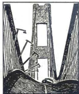
**36104** Nel 1940 il ponte sospeso di Tacoma Narrows, nello Stato USA di Washington, collassò alcuni mesi dopo l'inaugurazione, sotto l'azione di venti di 60-70 km orari.
